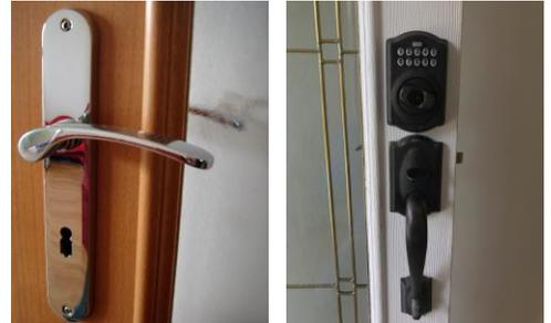
*Une poignée de porte à levier (à gauche) et un clavier de serrure (à droite) sont des adaptations qui peuvent être utilisées.<sup>13-14</sup>*
